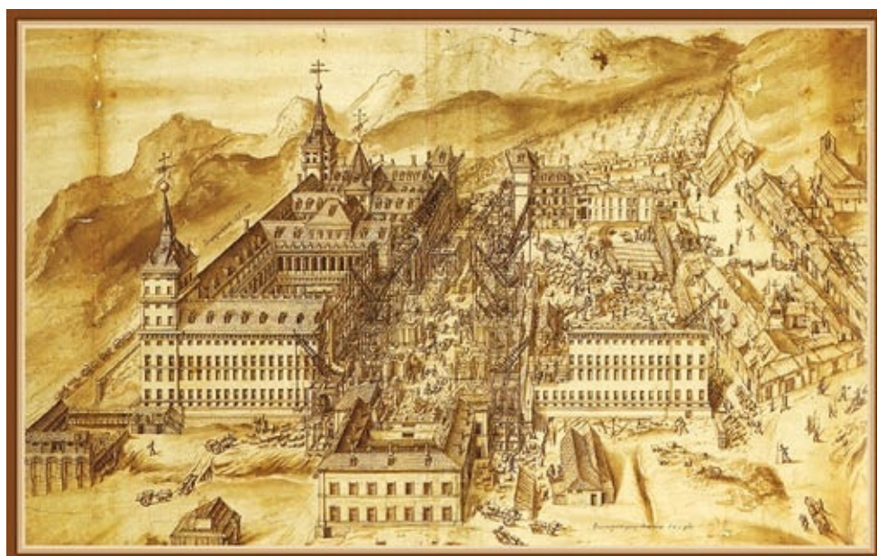
El Monasterio del Escorial en obras. Dibujo atribuido a Fabrizio Castello o Rodrigo de Holanda. Colección del marqués de Salisbury. Hatfield House, Londres. Este dibujo nos muestra las obras del Escorial en 1576. Se puede ver perfectamente cómo eran las técnicas de construcción de la época, así como la intensa actividad que se desarrolló, consiguiendo su finalización en un tiempo récord para la época. El mismo monarca que lo proyectó tuvo el privilegio de verlo acabado tan solo veintiún años después.
